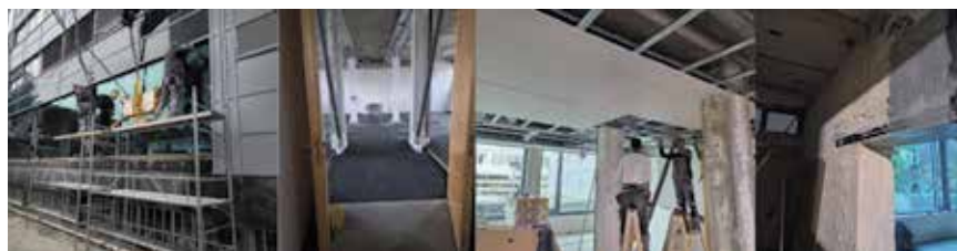
Slika 9. Zgrada tijekom energetske obnove
