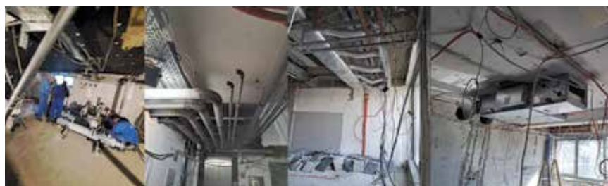
Slika 10. Zgrada tijekom energetske obnove
