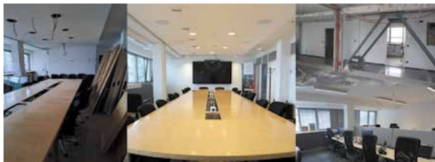
Slika 11. Zgrada tijekom i nakon energetske obnove
